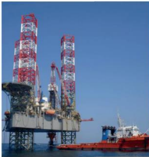
Piattaforme in mare
