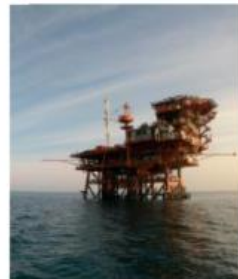
Una piattaforma offshore
