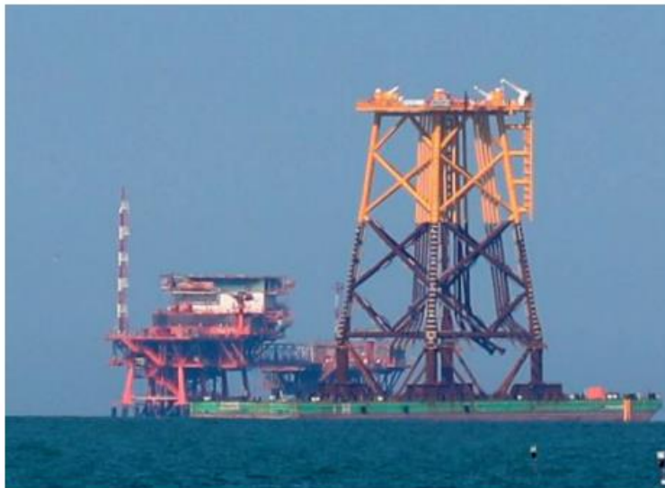
La parte sommersa di un impianto eolico partita ieri per la Francia: pesa 1500 tonnellate ed è alta 60 metri (foto Zani)
