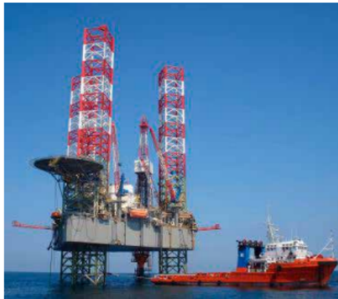
Una delle piattaforme
