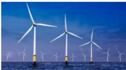
Un impianto eolico in mare
