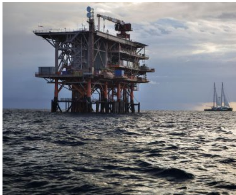
Una piattaforma offshore a Ravenna
