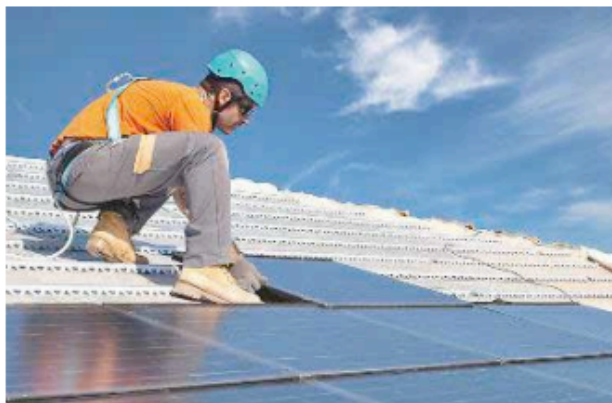
Il montaggio dei nuovi kit porta a 222mila quelli installati in tutto nel Paese
