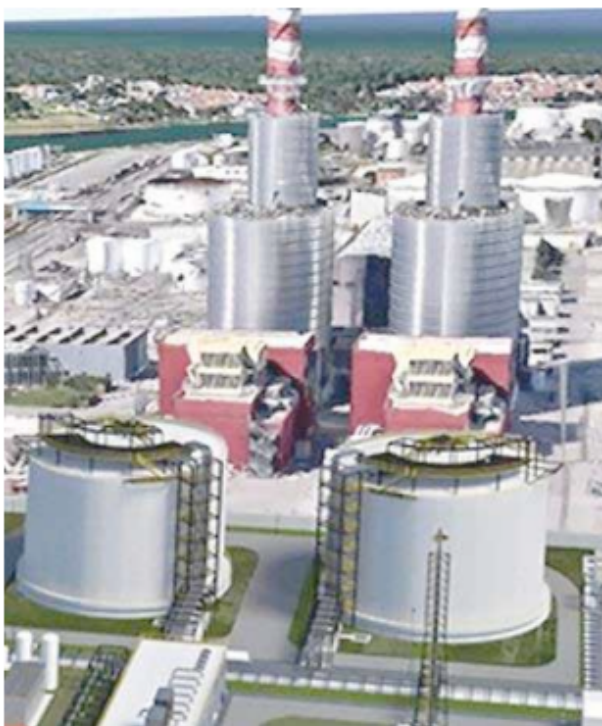
Un rendering di come sarà il deposito di gas naturale liquefatto in costruzione
