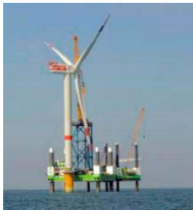
Il montaggio di un pala eolica
